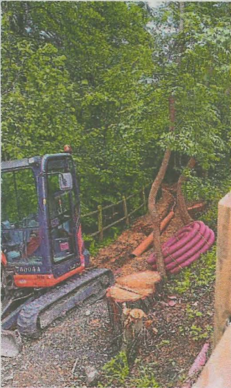
Obras en el Paseo de Hambre.
