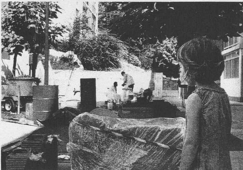
Trabajos de instalación de los nuevos equipamientos en la plazoleta de Ongarai / A.L.
