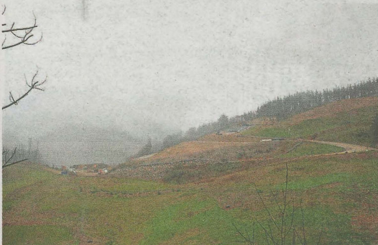
Los escombros de 2020 han dado paso a una ladera verde y marrón.
