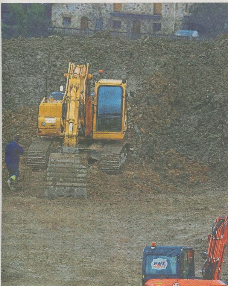
Operarios trabajan en el acondicionamiento del terreno.
