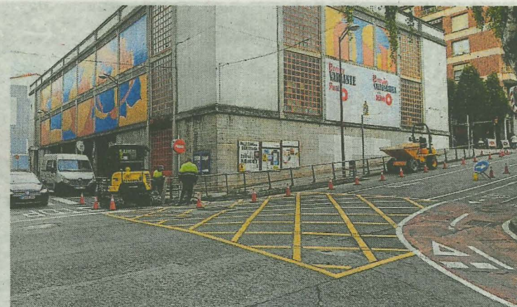
Han concluido las obras ejecutadas esta semana en VI Centenario. A. L.
