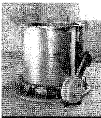
Uno de los 16 casquillos instalados.
