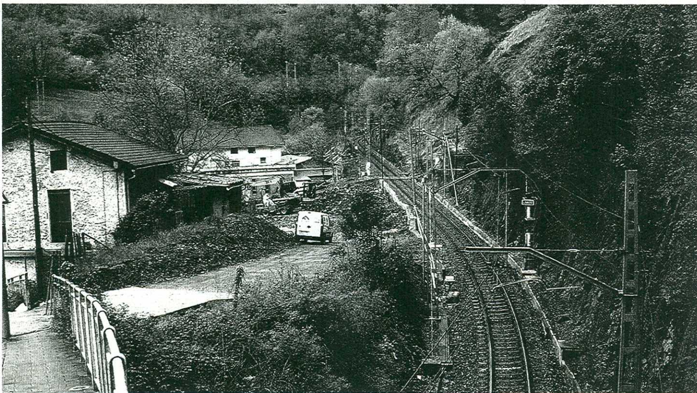
AMPLIACIÓN DE LA RED. Obras que se ejecutan en la red ferroviaria frente a la Universidad Laboral para desdoblar el trazado. / A.R.
