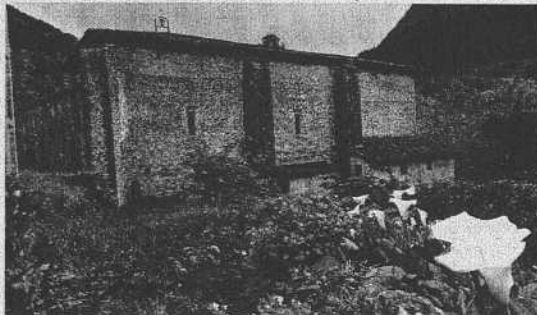
Estado que presenta el monasterio de Sasiola. /DAVID APREA
